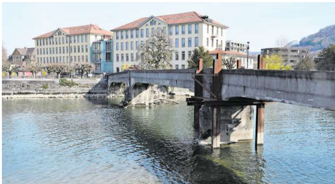
Aktuell wird die Spinnereibrücke mit Stahlprofilen gesichert.
